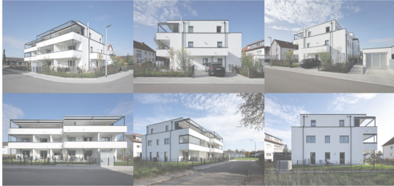
Referenz Mehrfamilienhaus Gensöderstraße
