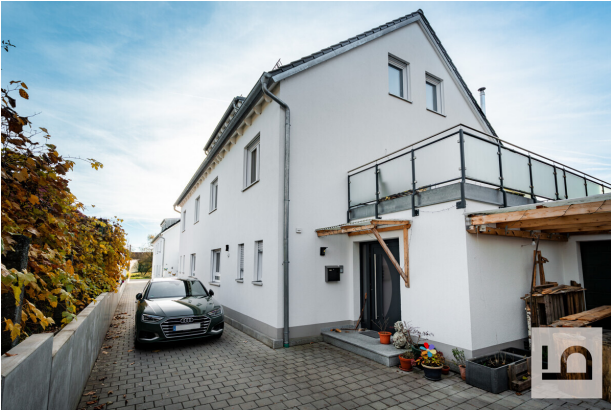
Ansicht Hauseingang und Hofeinfahrt
