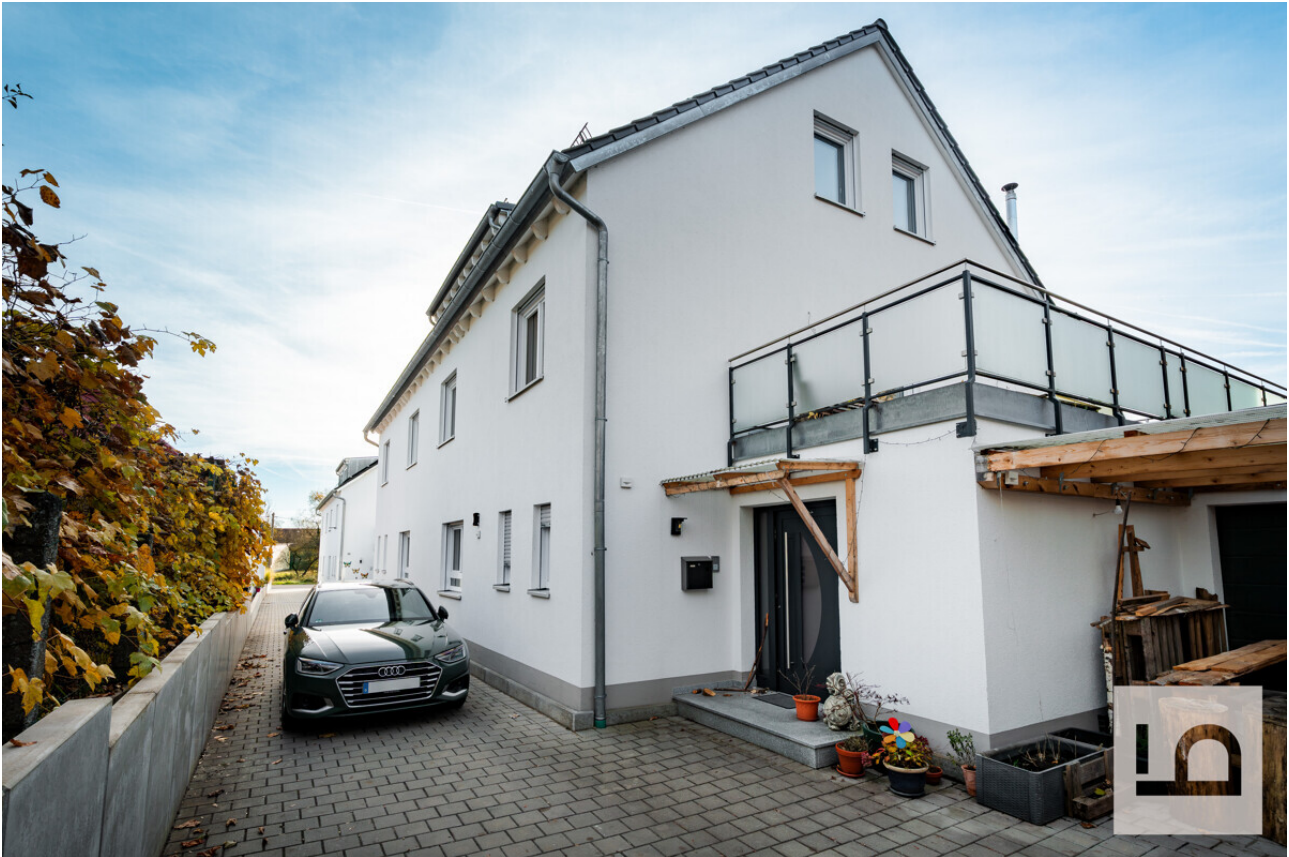
Ansicht Hauseingang und Hofeinfahrt
