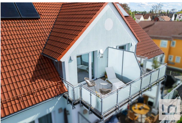
Balkon mit Westausrichtung rohrenansicht
