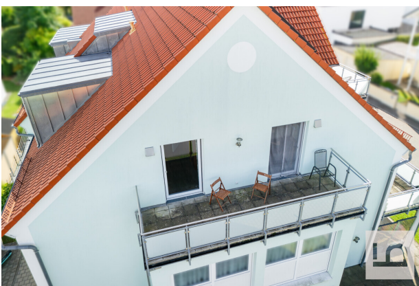
Ansicht Balkon Nordseite
