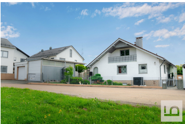
Hausansicht mit Garagen
