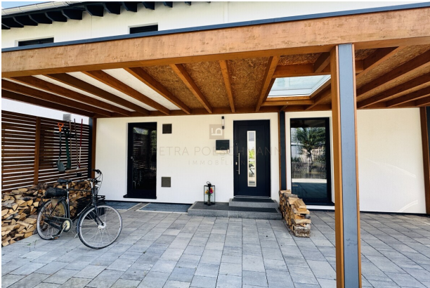
Carport mit Eingangsbereich
