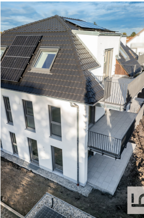
Balkon und Terrassenansicht
