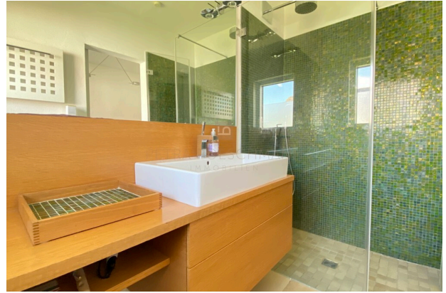
Bad mit Dusche im OG
