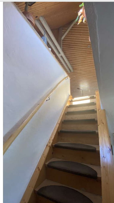
Treppe zum OG
